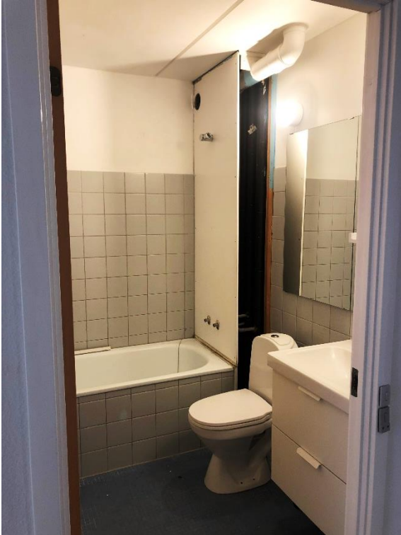
I to af de besøgtede boliger blev siden af installationskassen i badeværelset demonteret.
