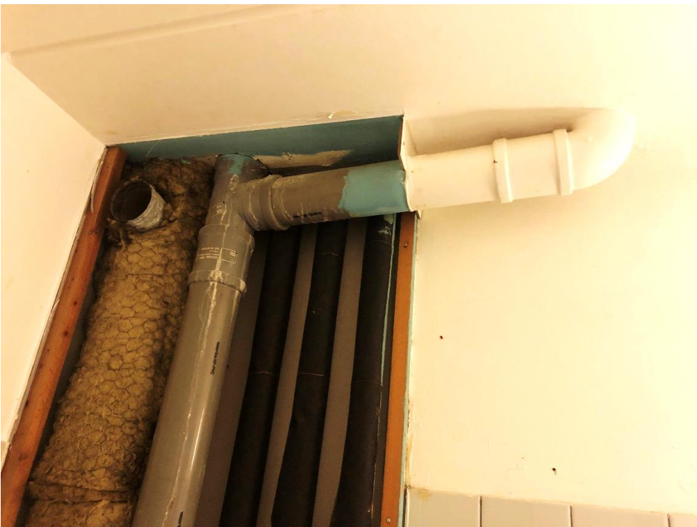
Afløb fra toilet samt gulv afløb/badekar/håndvask på overliggende bolig.
