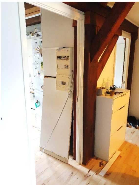
Skakt i køkken. Placeret mellem væg/søjle og køkkenindretning. I to af de besøgte boliger var den ene side af installationskassen delvist demonteret. (Fotos'ne er fra to spejlvendte boliger.)
