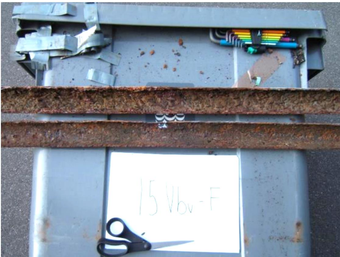
Rørprøve udtaget på kælderledning for varmt vand i nr. 15 med 30 % afsætning og 90-100 % tæring.
