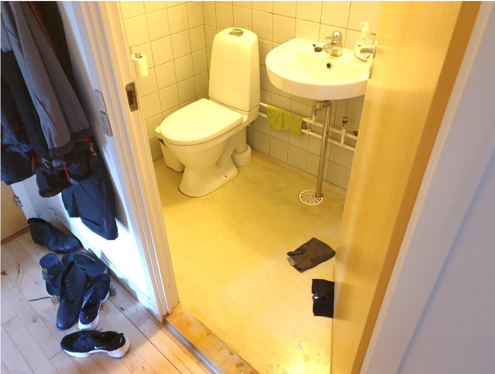
Badeværelse, uden skakt. Vandrør er ført synligt på væg.
