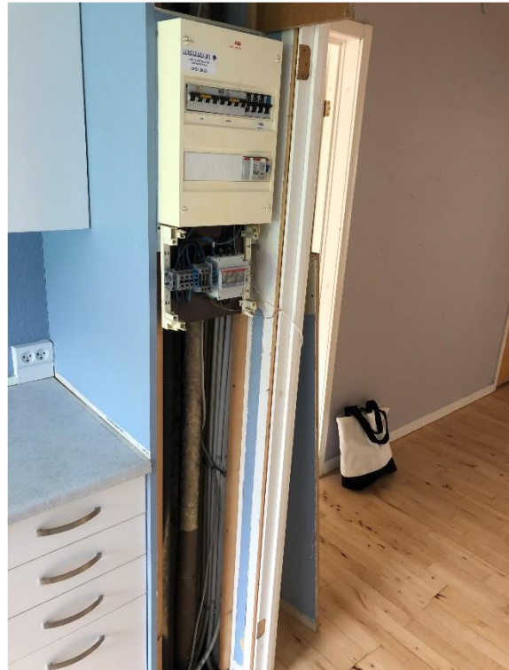
Det øverste og nederste af skaktens side blev demonteret, mens el-tavlen blev hængende. Forrest står varmerør, derefter udsugningskanalen og bagerst står faldstammen af støbejern.
