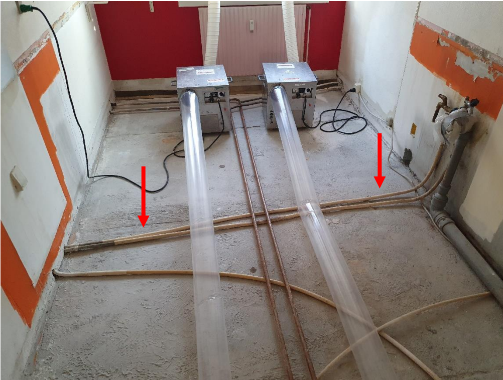
Foto fra køkkenet, hvor kobberørene er ført op til forsyning af køkkenvasken.
