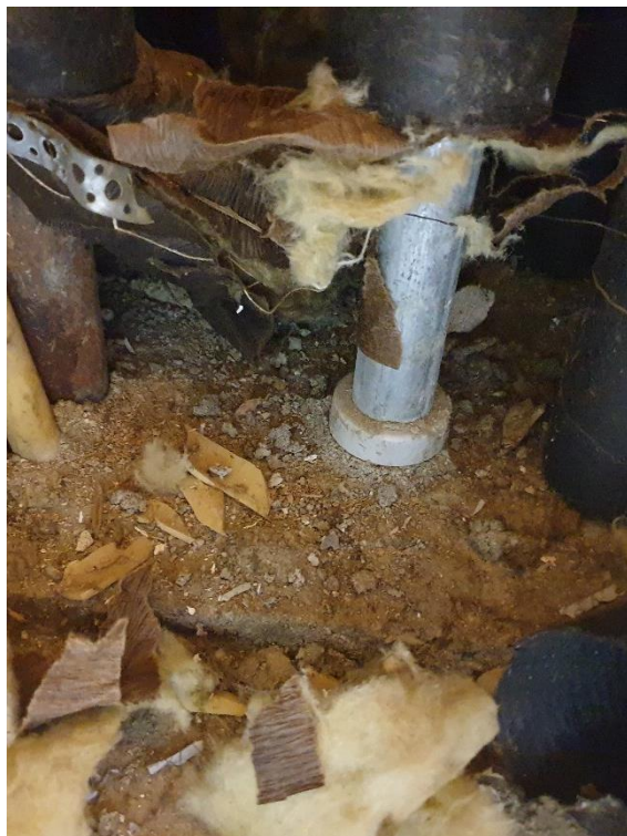
Udskåret rørstykke, der lå i badeværelsesskakten i en bolig, ved gennemgangen. Tydelige tegn på korrosion.
