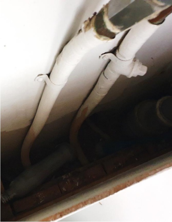
Vandrør til køkken ført under gulv og op til køkkenvask.
