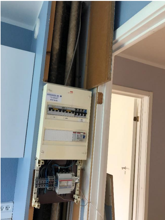
Det øverste og nederste af skaktens side blev demonteret, mens el-tavlen blev hængende. Forrest står varmerør, derefter udsugningskanalen og bagerst står faldstammen af støbejern.
