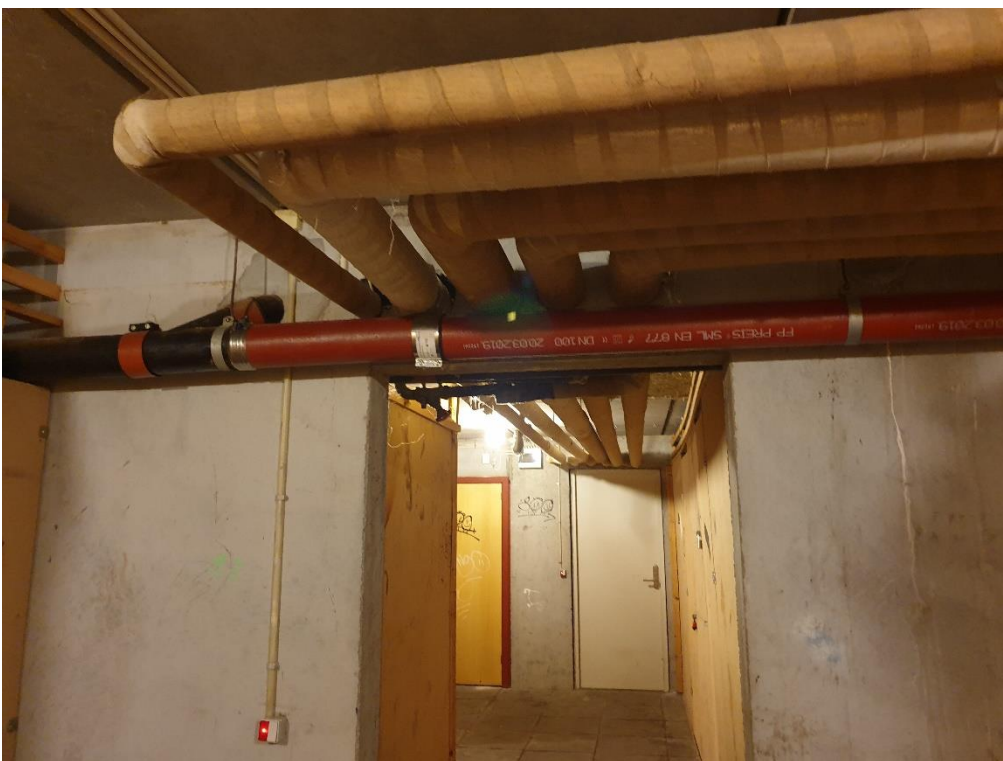
Partiel udskiftning af afløbsrør i kælder.
