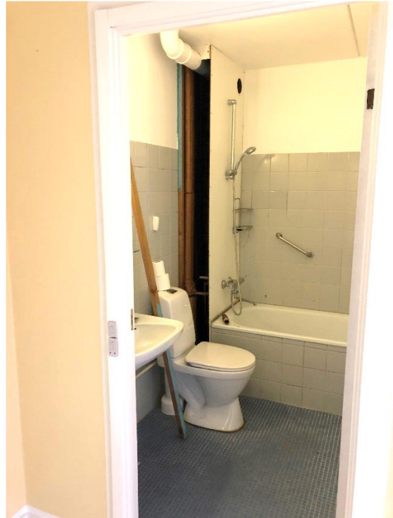
I to af de besøgtede boliger blev siden af installationskassen i badeværelset demonteret.
