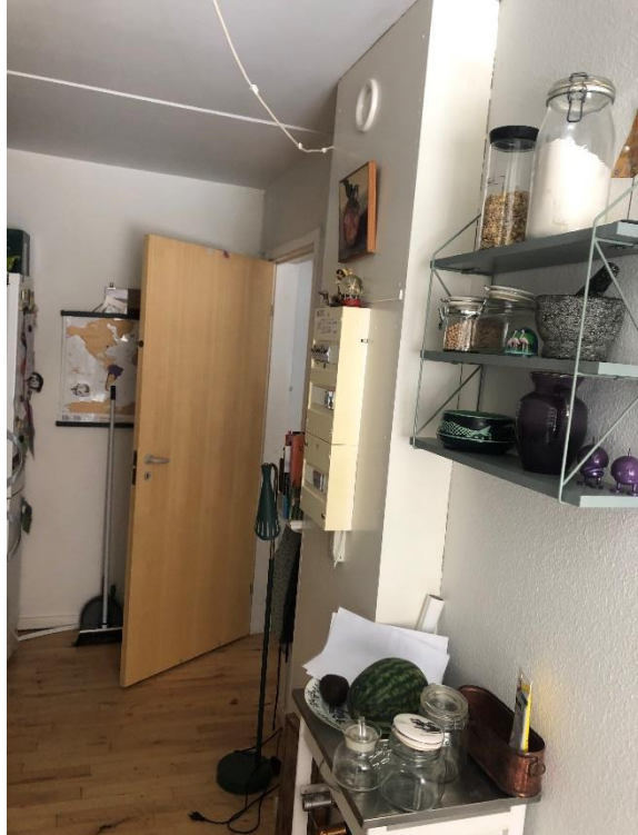
Skakten i entréen er placeret i det ene hjørne af rummet. Bemærk, at afløbet er ført synligt, og det nuværende plastrør medfører kraftige lydgener i boligen.
