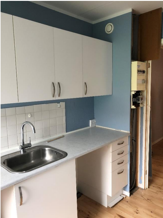
I to af de besigtigede boliger blev siden af installationskassen i køkkenet demonteret.
