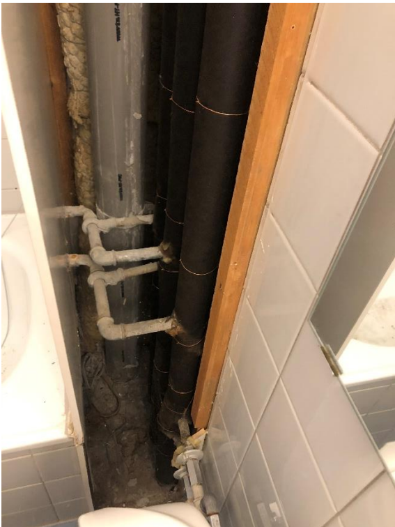
Forrest står vandrørene af galvaniseret stål, derefter faldstammen af plast og bagerst udsugningskanalen. Afgreningerne til brusearmaturet og til toiletet/håndvasken er synlige. Afgreningerne til køkkenvasken er udført ved gulvet/skjult i gulvet.
