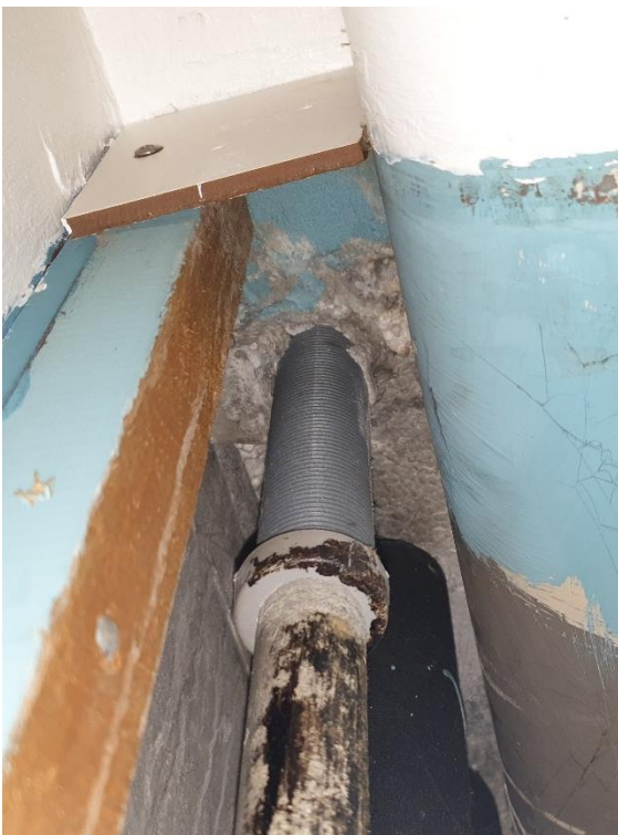
Bøsningsrør, som vurderes at være uden asbestsnor.
