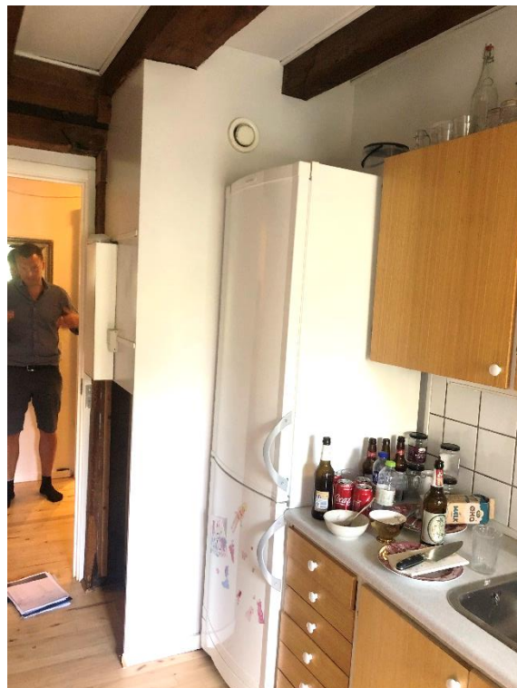
Skakt i køkken. Placeret mellem væg/søjle og køkkenindretning. I to af de besøgte boliger var den ene side af installationskassen delvist demonteret. (Fotos'ne er fra to spejlvendte boliger.)
