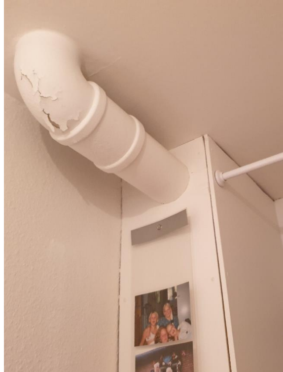
Skakten i entréen er placeret i det ene hjørne af rummet. Bemærk, at afløbet er ført synligt, og det nuværende plastrør medfører kraftige lydgener i boligen.
