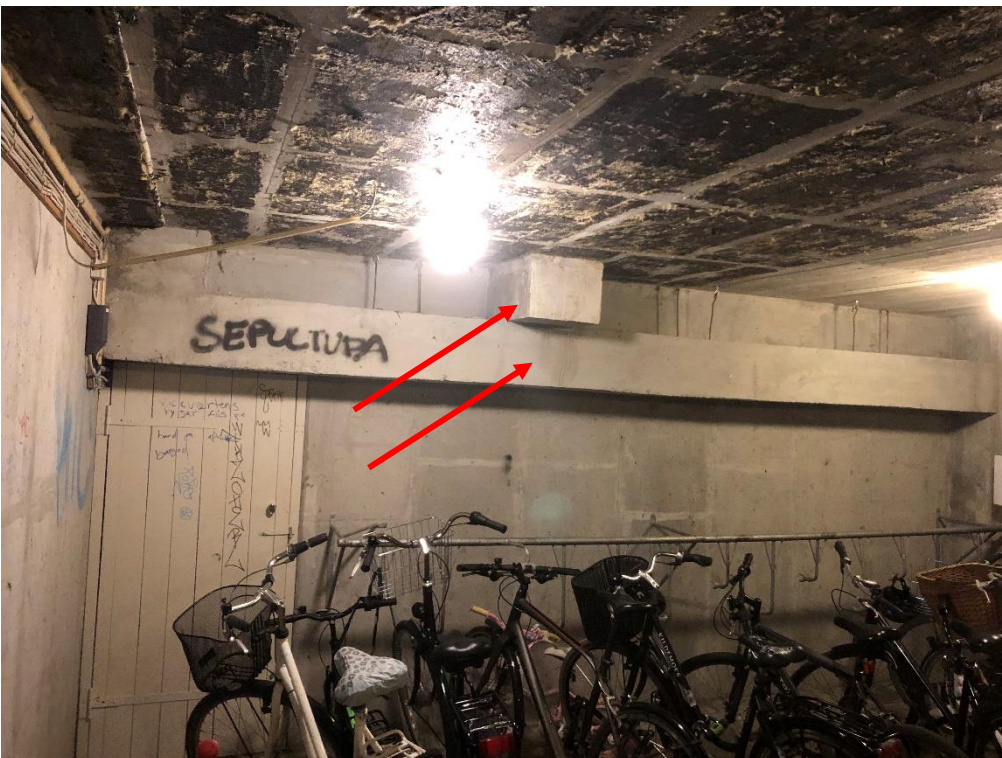
I de dele af kælderen, der er indrettet til sikringsrum, er afløbene omstøbt med beton.
