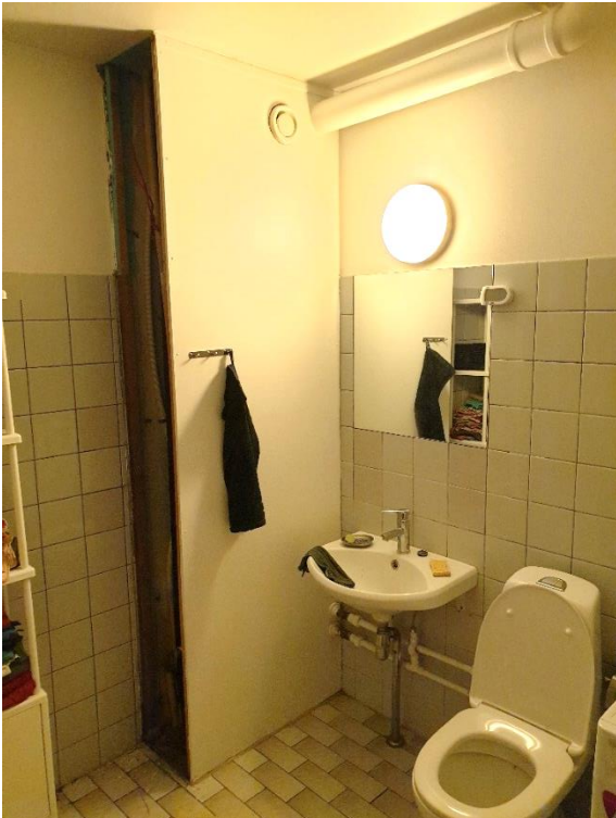
Skakt i badeværelse, i bolig med handicapvenlig indretning. Skakten side blev demonteret. Der er ført installationer ud gennem kassens front.
