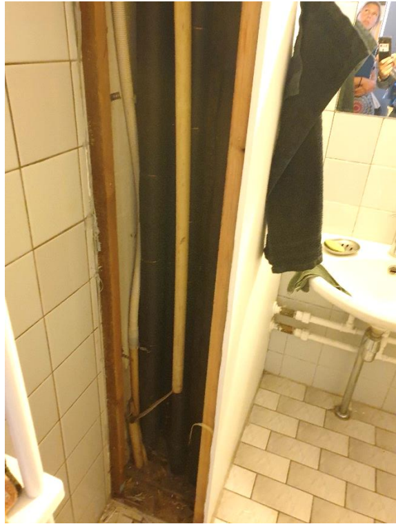
Skakt i badeværelse, i bolig med handicapvenlig indretning. Skakten side blev demonteret. Der er ført installationer ud gennem kassens front.
