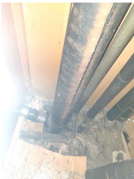
Kig ind i skakten i køkkenet. Fotoet er taget i en bolig på 1. sal i blok P, og udsugningskanalen er derfor kun ført ned til umiddelbart under loft i denne bolig.
