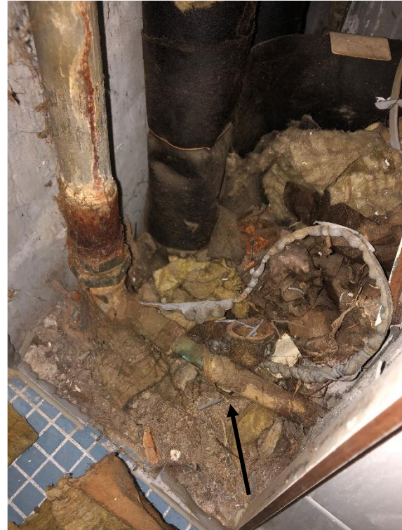
Forrest står vandrørene af galvaniseret stål, derefter faldstammen af plast og bagerst udsugningskanalen. Afgreningerne til brusearmaturet og til toiletet/håndvasken er synlige. Afgreningerne til køkkenvasken er udført ved gulvet/skjult i gulvet.
