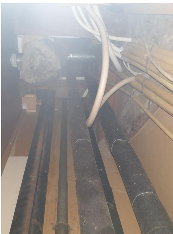
Kig ind i skakten i køkkenet. Fotoet er taget i en bolig på 1. sal i blok P, og udsugningskanalen er derfor kun ført ned til umiddelbart under loft i denne bolig.
