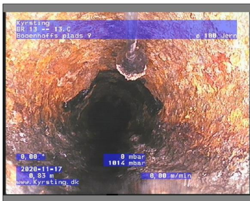
Foto: BR 13-13.CBoenhoffs plads 95-SI_Spare5_A.JPG, Medie #: 24-08-2020, 00:00:43 0,83m, Aflejring klasse 3, fra urref 3 til urref 9, Hårde materialer, Fastsiddende, Start
