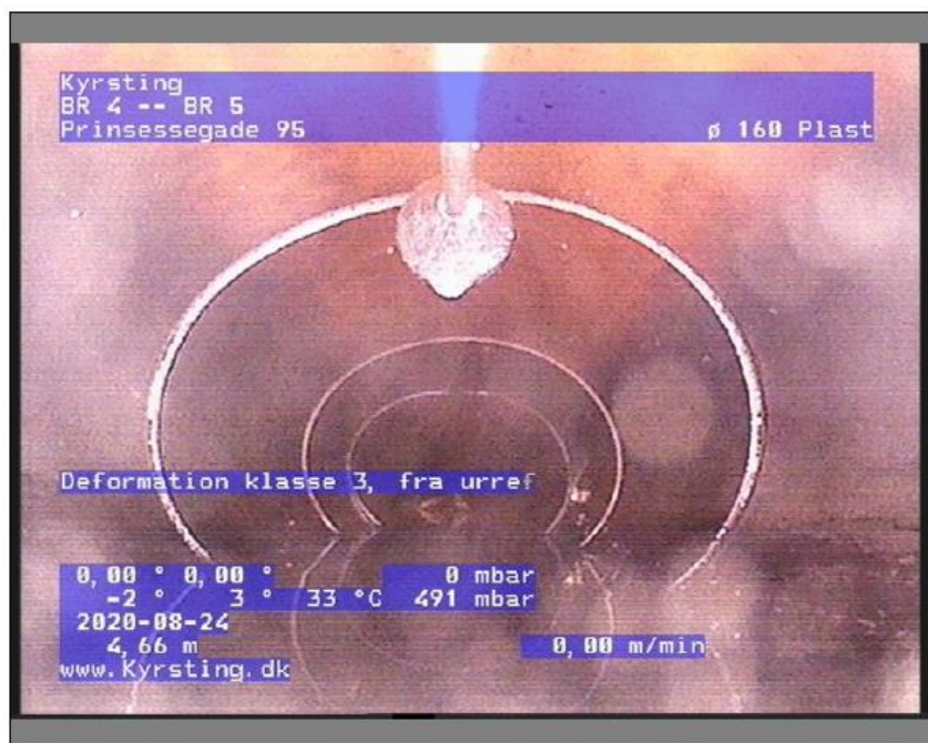
Foto: BR 4-BR 5Prinsessegade 955-SI_Spare5_A.JPG, Medie #: 24-08-2020, 00:02:10 4,66m, Deformation klasse 3, fra urref 00 til urref 12, Vertikal deformation, Start
