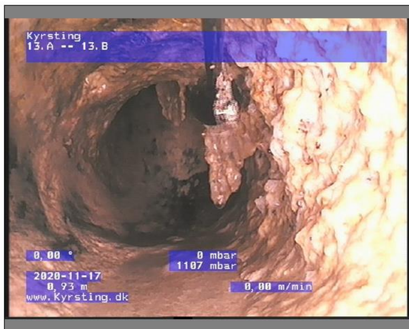
Foto: 13.A-13.BBoenhoffs plads 96-SI_Spare5_A.JPG, Medie #: 24-08-2020, 00:00:44 0,93m, Belægninger klasse 3, fra urref 00 til urref 12, Kloakhud, På rørvæg, Stop
