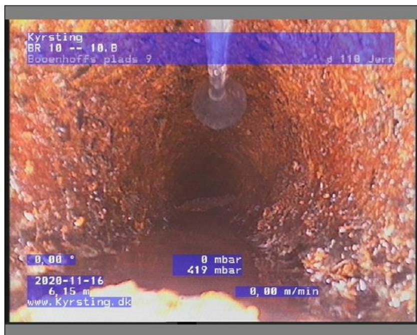
Foto: BR 10-10.BBoenhoffs plads 914-SI_Spare5_A.JPG, Medie #: 24-08-2020, 00:03:13 6,15m, Overfladebeskadigelse klasse 3, fra urref 00 til urref 12, Start
